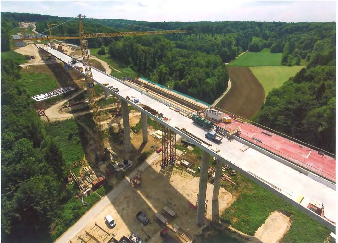
Ein Highlight im Strassenbau: Autobahn-Brückenbau bei Boncourt. Bilder: Infra
