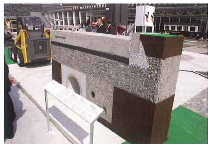
Auf einer Spielplattform zeigen Strassenquerschnitte in Originalgrösse, was in unseren Verkehrswegen aus Beton und Asphalt alles steckt
