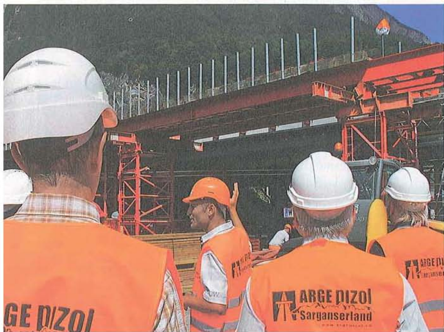
Chef-Bauführer Kunstbauten, Matthias Fischer, erläutert den Studierenden, wie komplex seine Grossbaustelle ist. Fotos: Fachverband Infra
