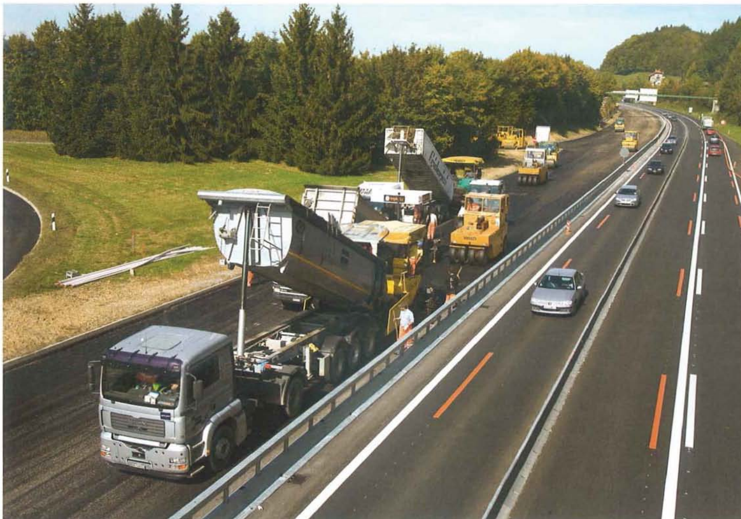
Baustelle auf der Autobahn bei Châtel-St. Denis. (Bild: Infra)
