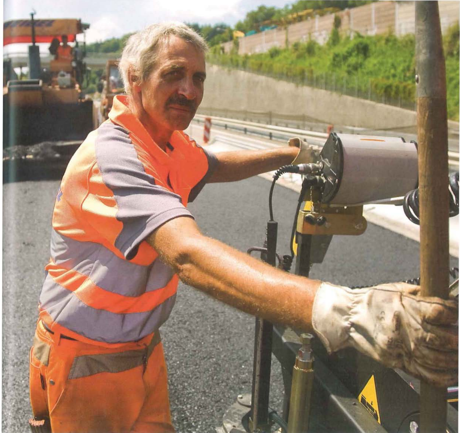
Arbeiten auf der Strecke Weyermannshaus-Flamatt. (Bild: Infra)
