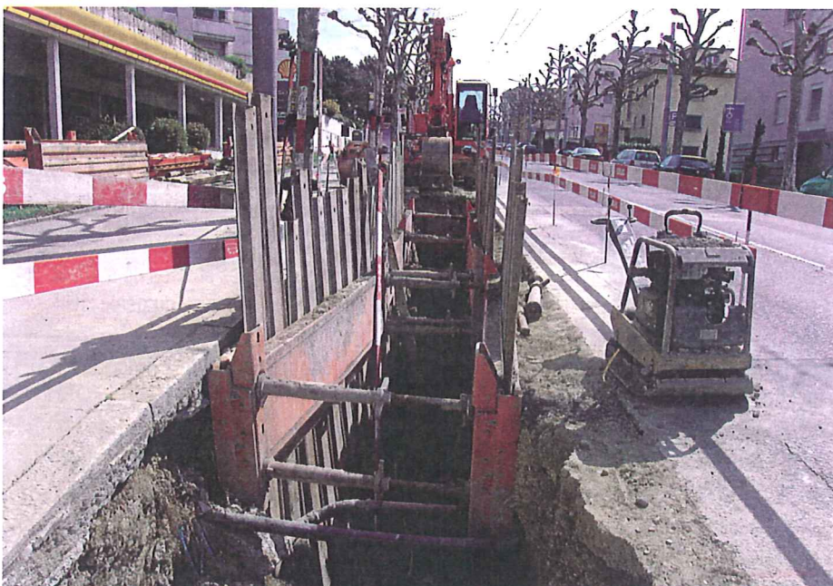
Les fouilles en tranchée en milieu urbain créent souvent diverses perturbations (entraves au trafic, nuisances sonores, etc.). D'autant plus si le chantier s'étend dans la durée. Dans ces cas-là, il est utile de recourir à d'autres systèmes, moins pénalisants.
